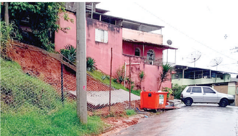
A escadaria que cedeu pelo impacto da lama e a providência paliativa
