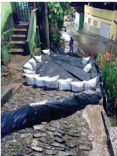
A escadaria que cedeu pelo impacto da lama e a providência paliativa
