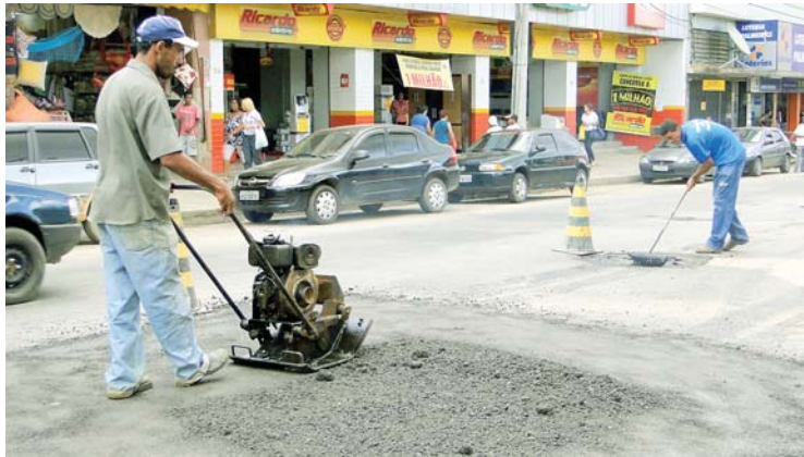
Operários aplicando massa asfáltica em Palmeiras
